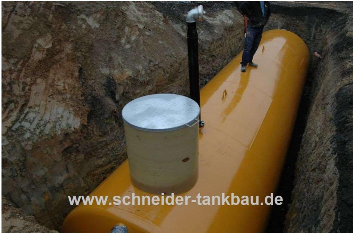
zur Lagerung von Regenwasser, Brauchwasser, Löschwasser, etc. D = 2,50 m, Länge = ca. 6,80 m
