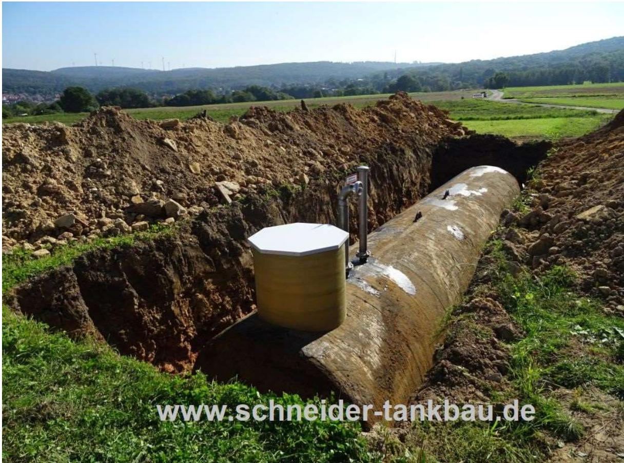
zur Lagerung von Regenwasser, Brauchwasser, Löschwasser, etc. D = 2,50 m, Länge = ca. 10,70 m
