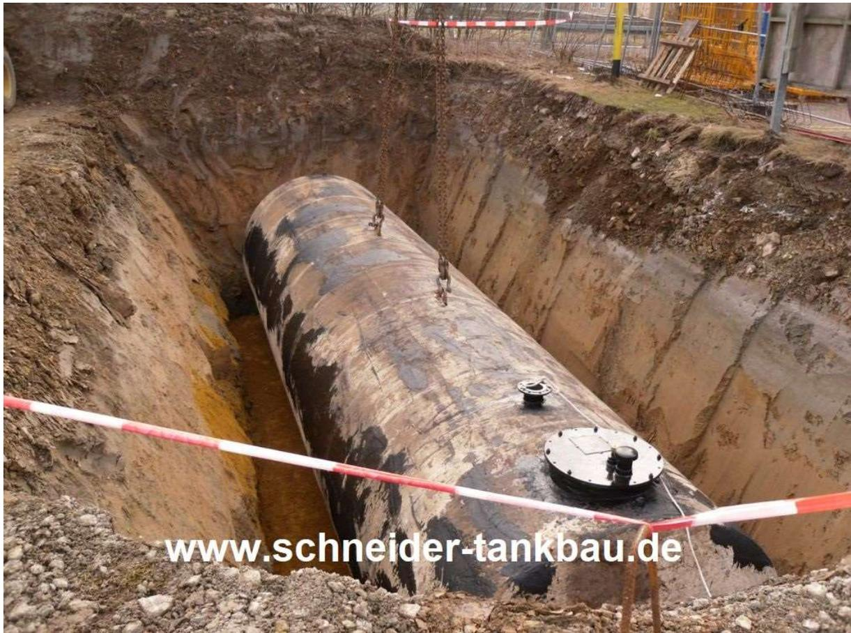
zur Lagerung von Regenwasser, Brauchwasser, Löschwasser, etc. D = 2,50 m, Länge = ca. 6,80 m
